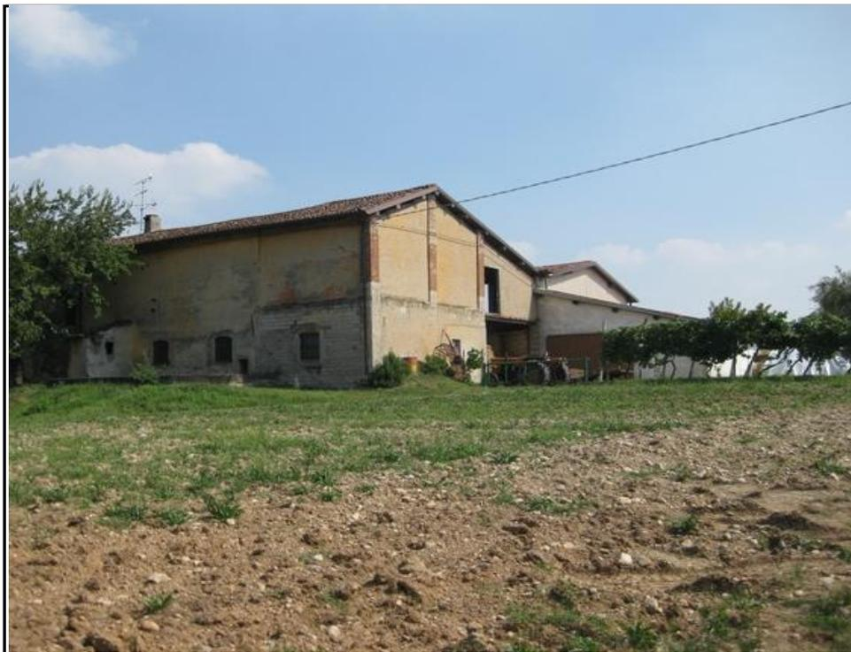
**Note descrittive:** Edificio a pianta rettangolare sviluppato su 2 piani, completamente intonacato e con armatura in cemento alle estremità E e W, il resto è costituito da una muratura in pietre spaccate e laterizi legati da un'abbondante quantità di malta. Il corpo a E è sovrastato da una merlatura a coda di rondine in laterizi. Alcune finestre sono semplici, di forma rettangolare e altre con piattabanda in laterizi.
