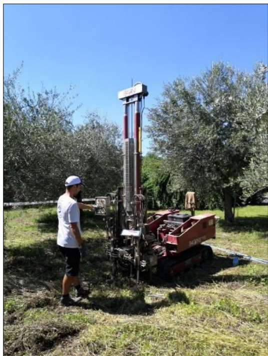
Esecuzione Prova Penetrometrica P5
