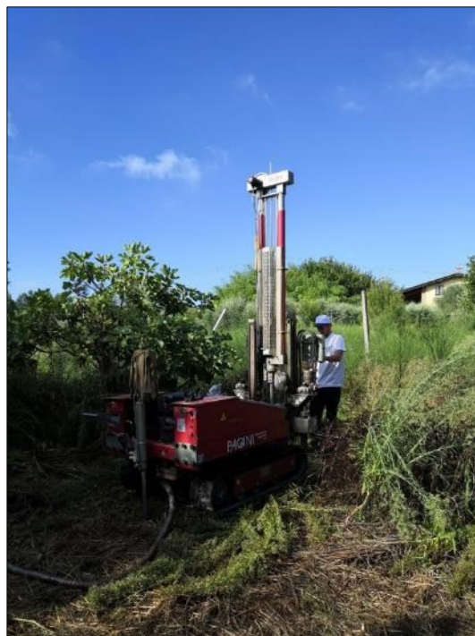
Esecuzione Prova Penetrometrica P2
