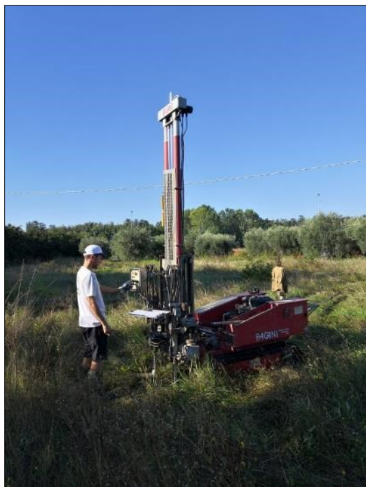
Esecuzione Prova Penetrometrica P1
