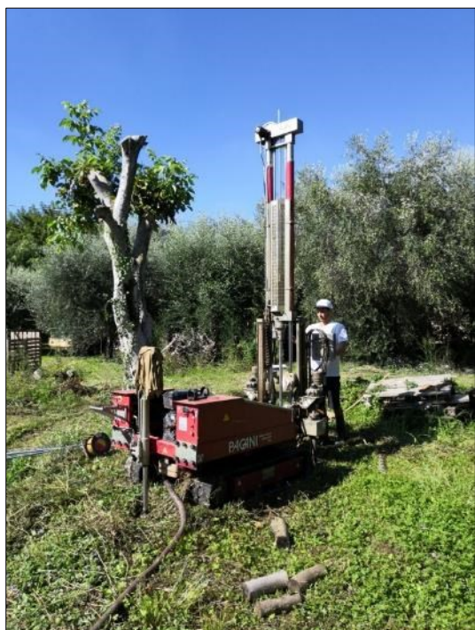
Esecuzione Prova Penetrometrica P3
