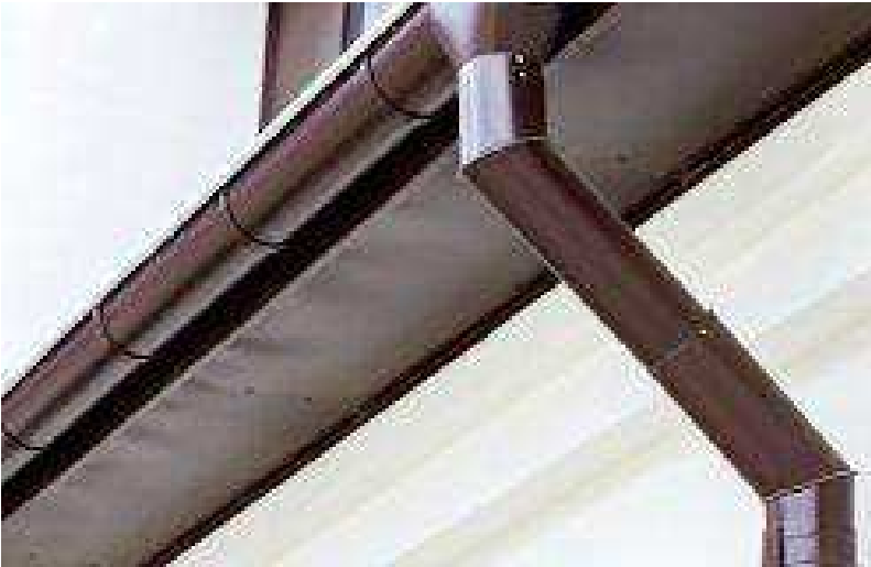
9.01 – Canali di gronda e pluviali in lamiera preverniciata color testa di moro
