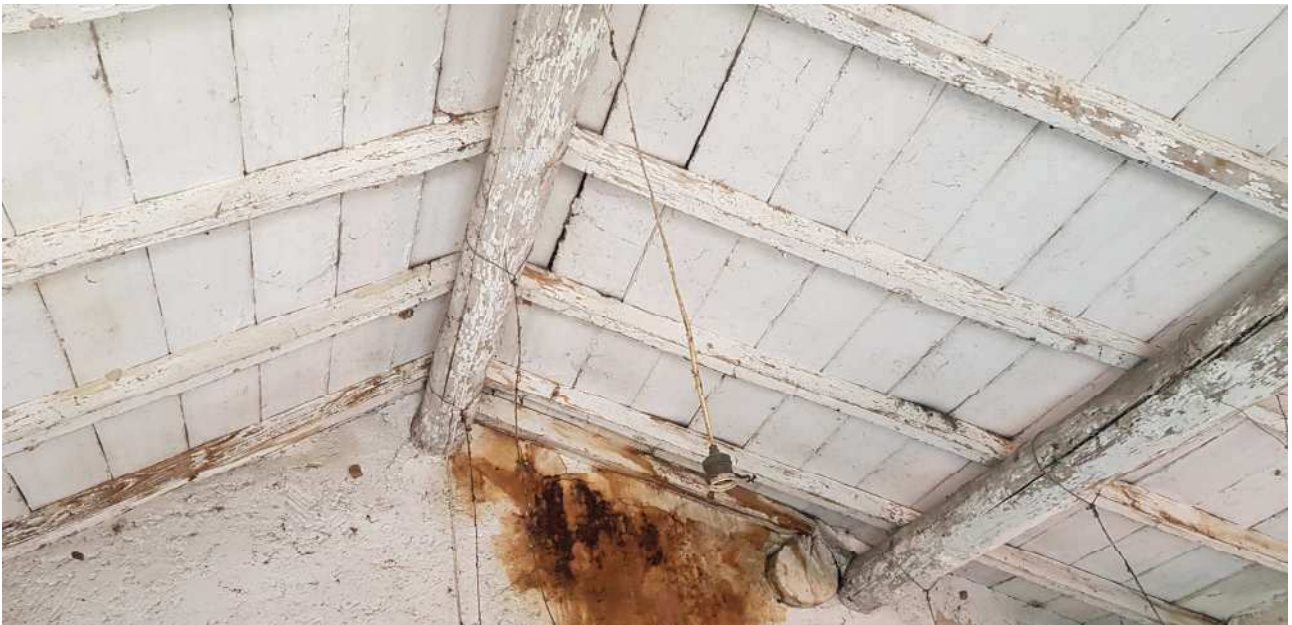
6.20 – copertura con travi a vista
