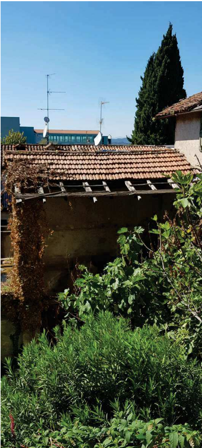
6.05 - Porzione di copertura crollata del porticato (per la corretta individuazione delle mancanze delle coperture fare riferimento alla tav. 04 e 05)
