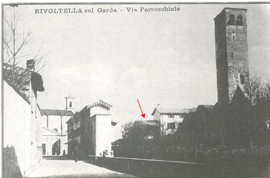
4.05 - Cartolina storica di Via Parrocchiale datata 21 Agosto 1918. A destra in prossimità della torre civica, una porzione dell'edificio oggetto d'intervento progettuale. A sinistra sul fondo, la Chiesa di San Biagio. Sotto la stessa porzione di edificio indicata su un'immagine attuale in cui si nota anche una parte dell'altana (edificata in fronte nord) costruita verosimilmente in fase successiva, contestualmente al resto dell'immobile, in quanto non la si rileva nella fotografia del 1918.
