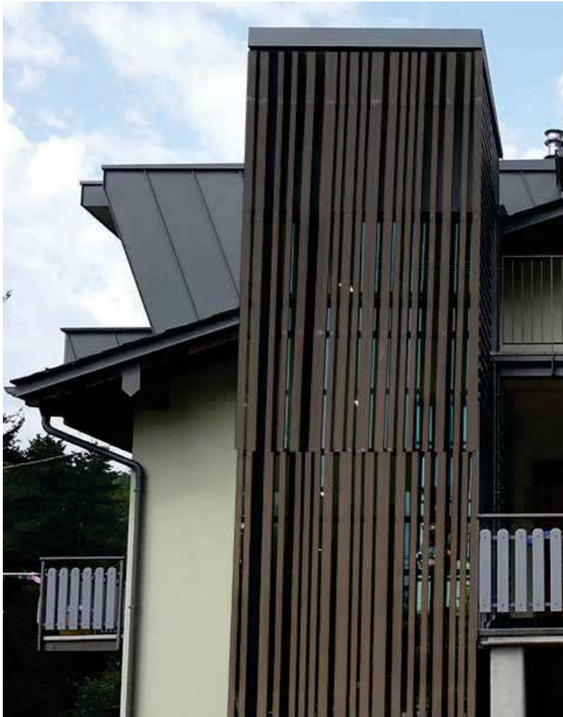
8.04 - Sistema di rivestimento del vano ascensore
