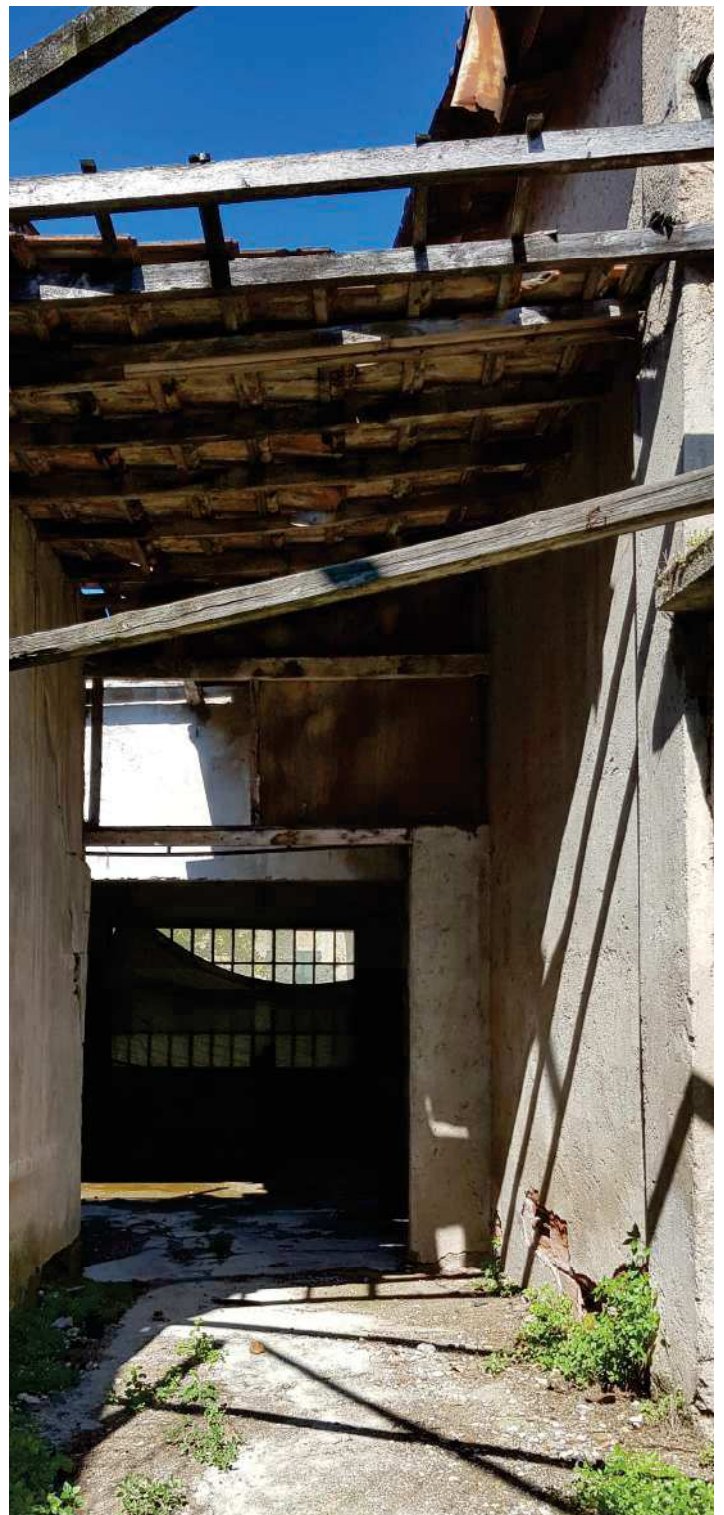
6.05 - Porzione di copertura crollata del porticato (per la corretta individuazione delle mancanze delle coperture fare riferimento alla tav. 04 e 05)
