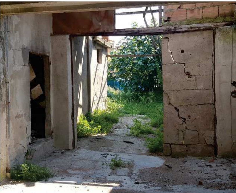
6.08 e 6.09 – Dettagli delle pareti e del solaio del magazzino al piano terra ulteriormente la criticità strutturale dell'edificio.
