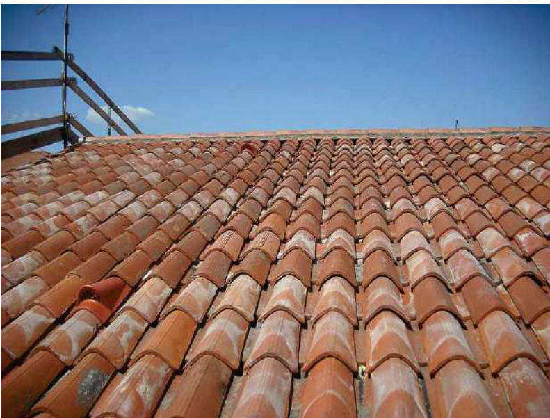
9.02 – Manto di copertura in coppi
