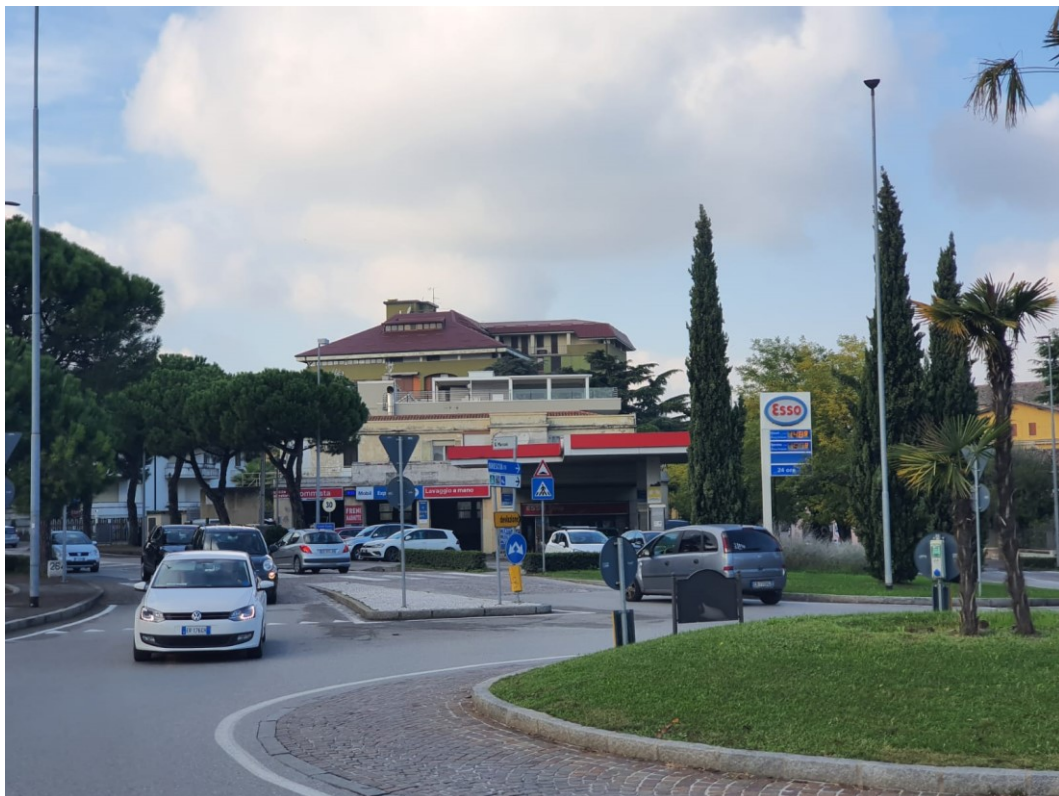
Figura 3 Vista prospetto Est
