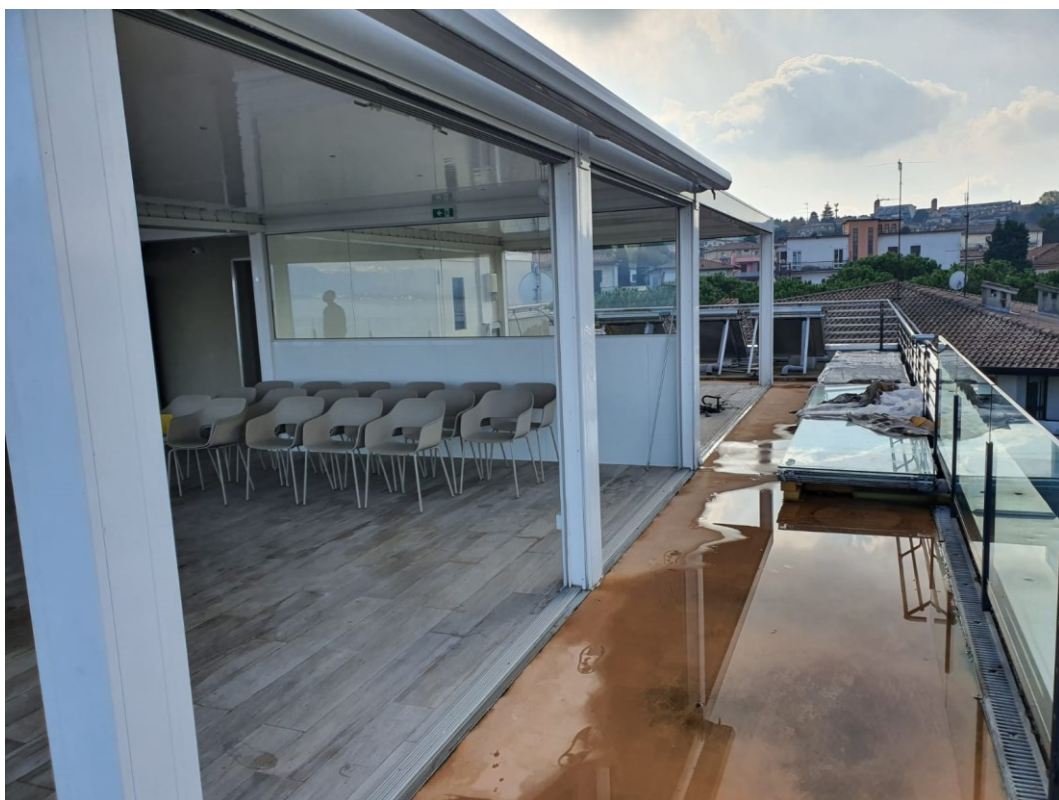
Figura 2 Vista prospetto Ovest
