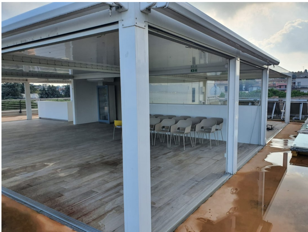
Figura 1 Vista angolo Nord Ovest
