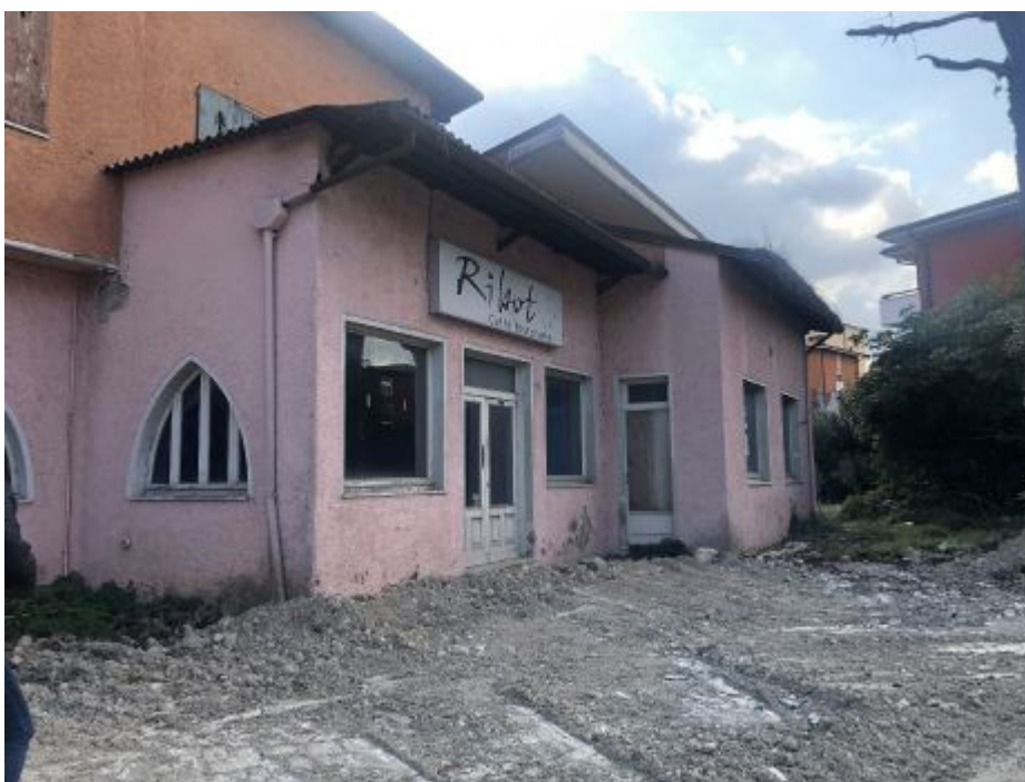
ingresso alla porzione di fabbricato che ospitava l'attività di ristorazione e ormai dismessa
