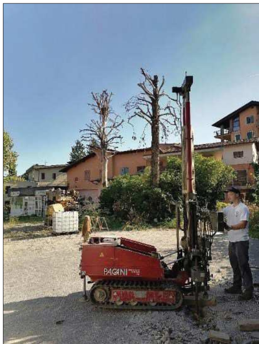
Esecuzione Prova Penetrometrica CPT-P1
