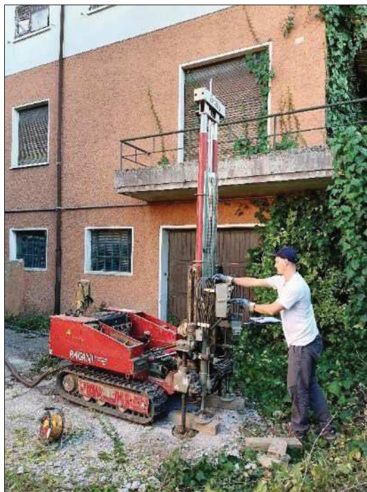
Esecuzione Prova Penetrometrica CPT-P2
