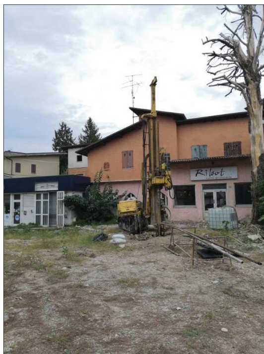
Postazione sondaggio – S1
