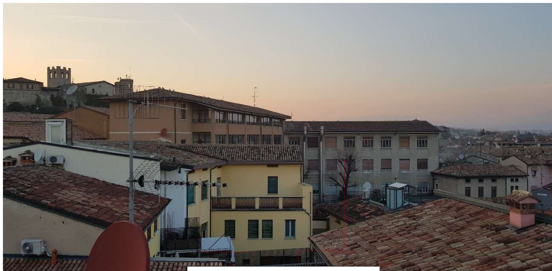
Edifici oggetto di intervento
