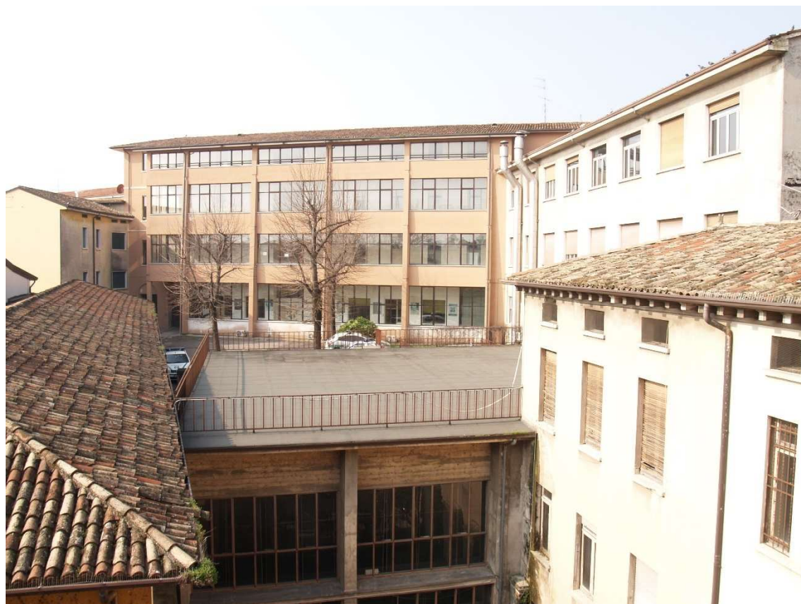
Edifici oggetto di intervento-vista di insieme da Nord-Est
