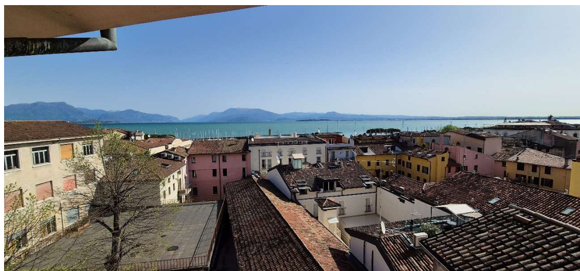
Edifici oggetto di intervento-vista di insieme da Sud-Est
