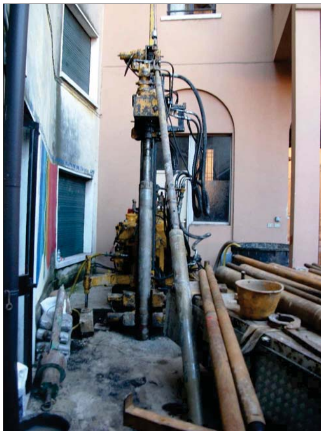
POSTAZIONE SONDAGGIO S1
